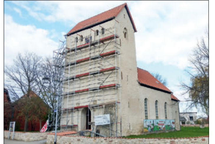
Die eingerüstete Kirche St. Georg bekommt zwei neue Glocken. Foto: privat
