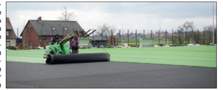
In Salzdahlum wurde der Kunstrasenplatz verlegt. Die Baumaßnahme befindet sich auf der Zielgraden. Foto: Stadt Wolfenbüttel
