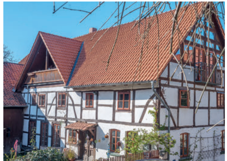
Viele toll erhaltene Fachwerkgebäude kann man in Hemkenrode bewundern, wie dieses beispielsweise. 1733 wurde es erbaut.
