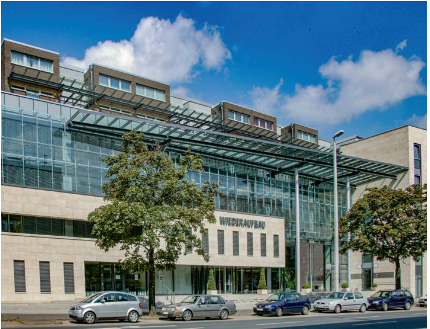
Das Verwaltungsgebäude der Baugenossenschaft >Wiederaufbau< eG in der Guldénstraße 25 in 38100 Braunschweig.
