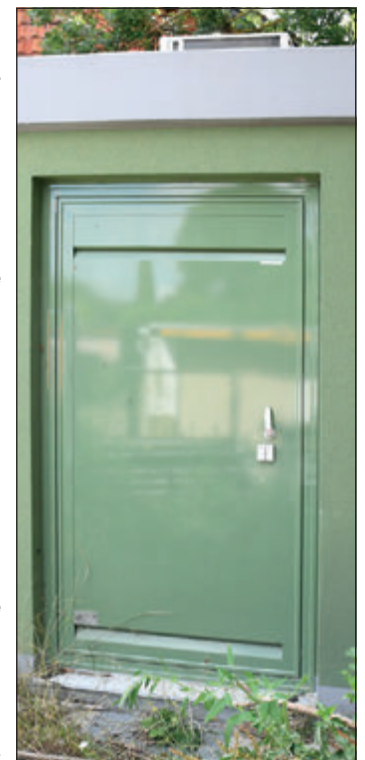
Hier laufen alle Fäden zusammen. Die Technikstation in Hornburg ist bereits für alle Neukunden ausgerüstet.
