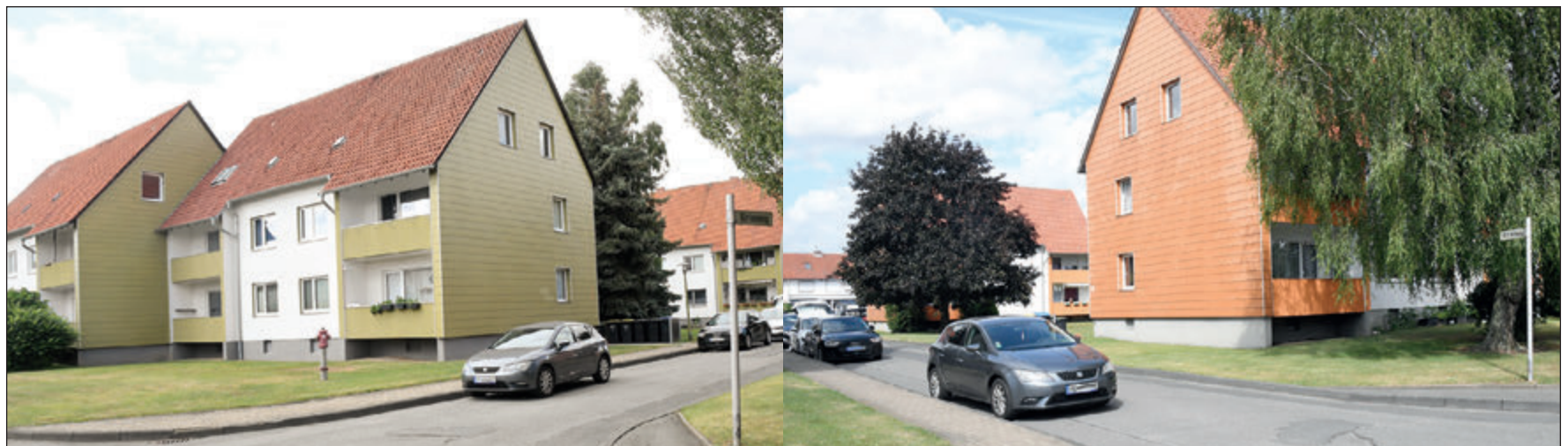
Im Birkenweg und im Eichenweg starten im August die Ausbauarbeiten für die Erschließung der Mehrfamilienhäuser.
