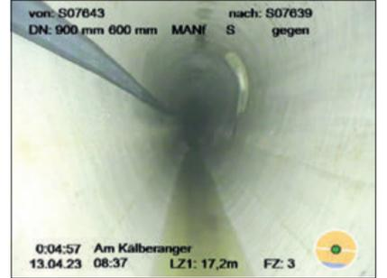
Nachher: Der ABW hat einen mit Harz getränkten Schlauch eingezogen, der ausgehärtet ist. So entstand ein neuer und dichter Abwasserkanal innerhalb des alten Kanals. Fotos: Abwasserbeseitigungsbetrieb der Stadt Wolfenbüttel
